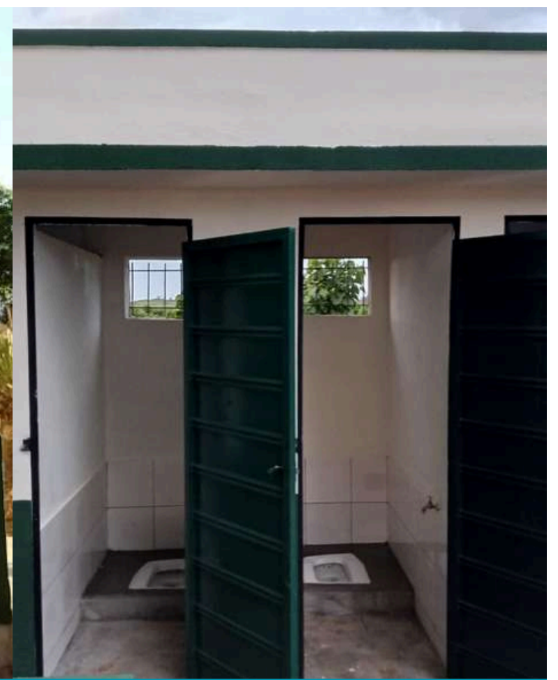
Intérieur du bloc sanitaire
