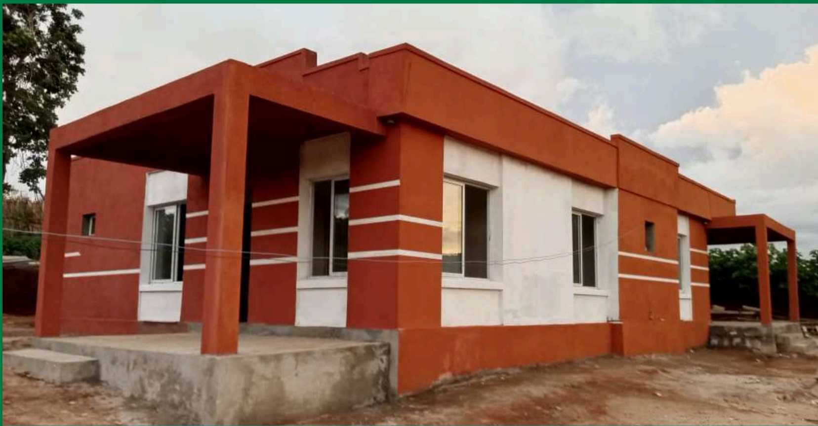
Centre de santé EN COURS de travaux (janvier 2025)
